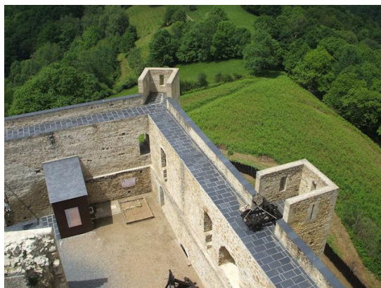
Les courtines vues du haut du donjon
